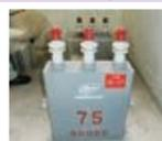
PCB(ポリ塩化ビフェニル)が使用されたものがあります。高濃度PCB使用機器を保有している方は、処理期限(来年3/31)までに、適正に処理してください。感電の恐れもあり大変危険ですので、確認作業は必ず電気主任技術者などにご相談ください。
