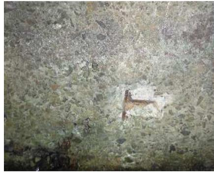
写真-鉄筋露出
