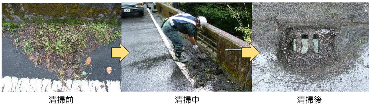
写真一 日常点検時の清掃状況(排水装置土砂詰り)
