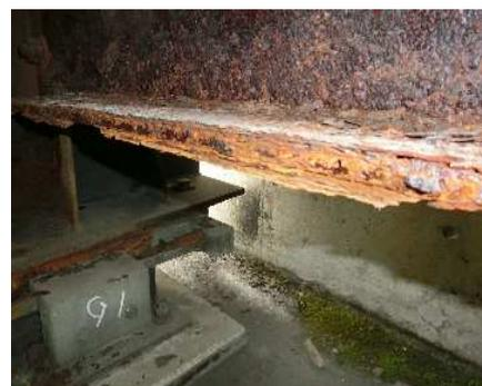
写真-主桁の腐食
