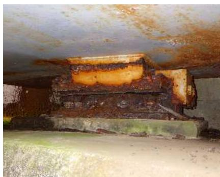
写真-支承部の腐食
