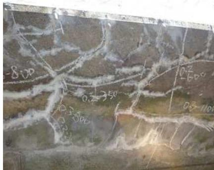
写真-亀甲状のひび割れ、遊離石灰
