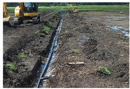
水田の汎用化を図る暗渠排水の施工
