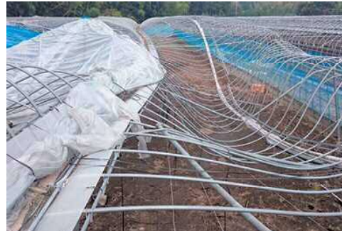
台風により損壊したハウス
