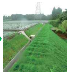
排水路整備による農地の崩壊防止
