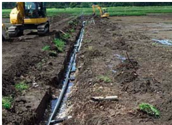
水田の汎用化を図る暗渠排水の施工
