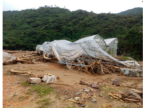
大雨により損壊したハウス
