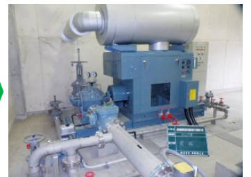
老朽化したポンプの補修
