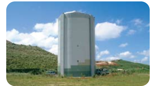
平尾台配水池 (小倉南区)
