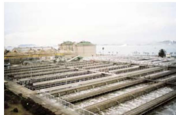
③浄化センター(日明浄化センター)
